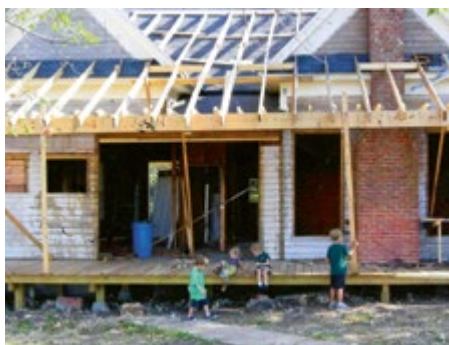
DAS FARMHAUS WÄHREND DER RENOVIERUNGEN.
